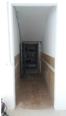
Fotografia 5. Vista de los almacenes 2 y 3
