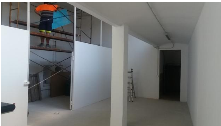
Fotografia 4. Vista del interior del almacén 1
